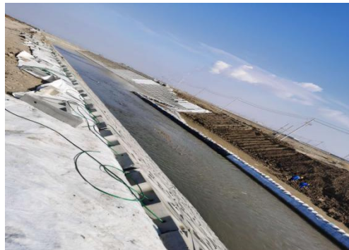
新建渠道护坡修建过程
