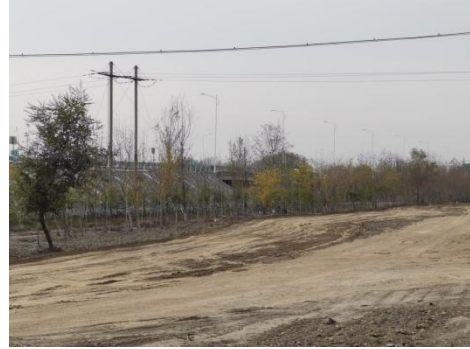
管道施工后植被土地恢复情况
